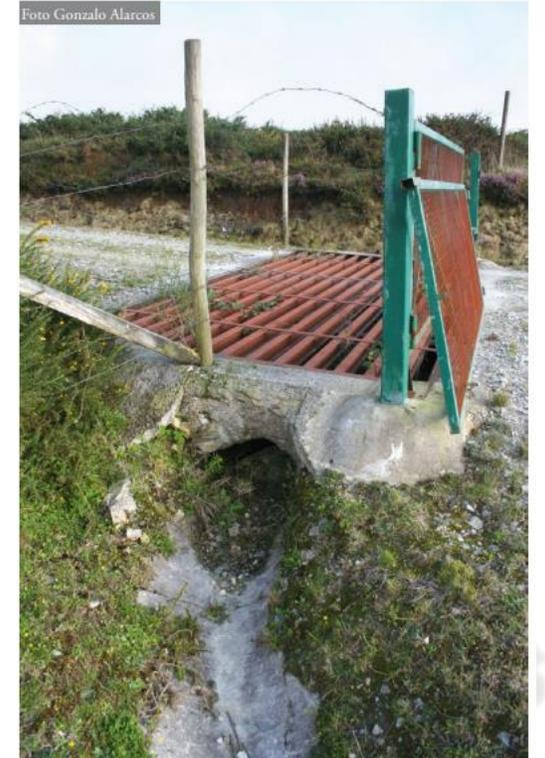
Figura 1: Ejemplo de modificación en paso canadiense con apertura de una de las paredes laterales para la salida de la fauna. Parque eólico en Cadavedo, Lugo.
